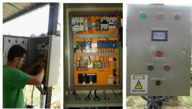
Fig. 5. Tablero de control conteniente el hardware desarrollado para el sistema automatizado de nebulización y riego por goteo de agua.
